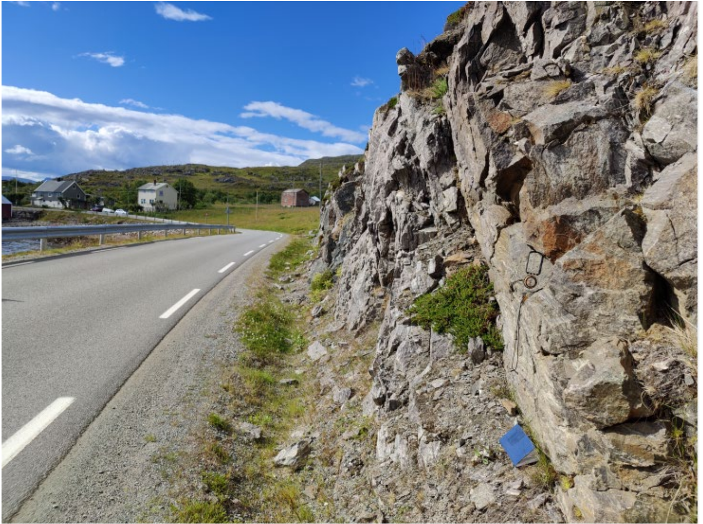
Figur 2-5: Glimmergneisen flaker opp langs foliasjon (i dette området langs F1) og primært langs NNV/SSØ (S1) sprekk. Se V02 for stereoplot
