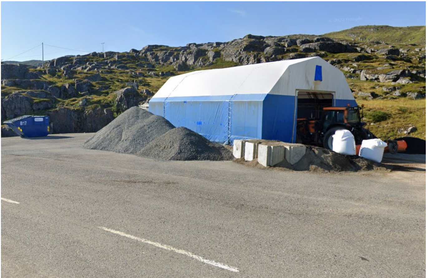
Figur 3-3: Oppbevaringstelt som er plassert på parkeringsplassen for Kjerringholmen ferjekai. Dette ligger ca. 6 meter nord om regulert område for masseuttak, og må mest sannsynlig flyttes før sprengningsarbeidene kan starte.
