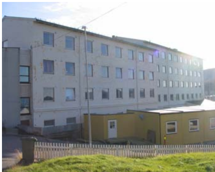
Kontrast: Tilbygget står ikke til hovedbygget. Materialbruk og takvinkel avviker sterkt.
