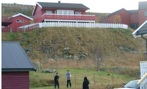
Selv med en slik løsning får vi en stor fylling. Likevel ville et hus i to etasjer beregnet for flat tomt i et slikt skrånende terreng gitt en mye mer dominerende fylling.
