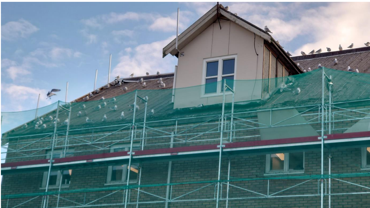
Renovering av Bibliotektaket
