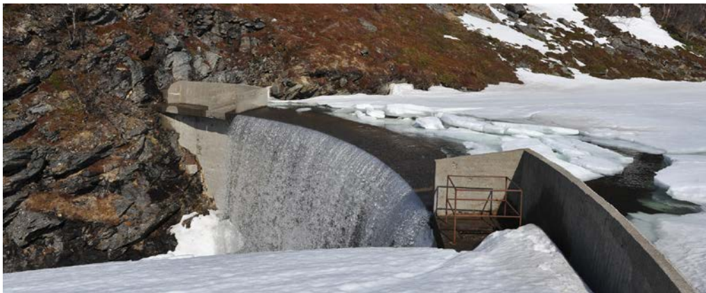
Demning, Inntaksdammen, Kvaløya
